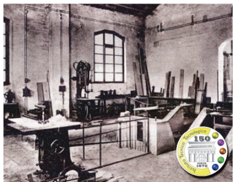
FOGGIA, ISTITUTO INDUSTRIALE "S. ALTAMURA" - REPARTO MACCHINE DA LEGNO
